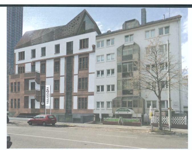
Die Voronoi-Diagrammen entlehnte Struktur zieht sich wie ein Gewebe über das Dach der „Villa Clara“, Architekten: Franken Architekten | The structure, based on Voronoi diagrams, settles like a web over the roof of Villa Clara, architects: Franken Architekten
