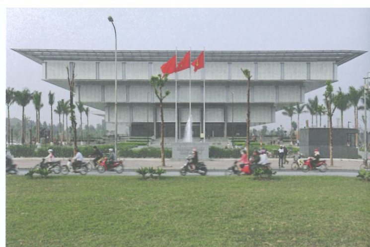
Museum für Geschichte und Kultur von Hanoi, Vietnam, Architekten: gmp | Museum for History and Culture of Hanoi, Vietnam, architects: gmp
